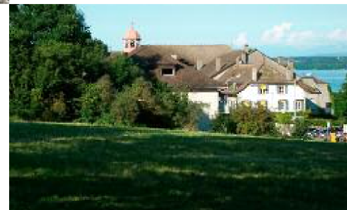
Entrée de Coppet
