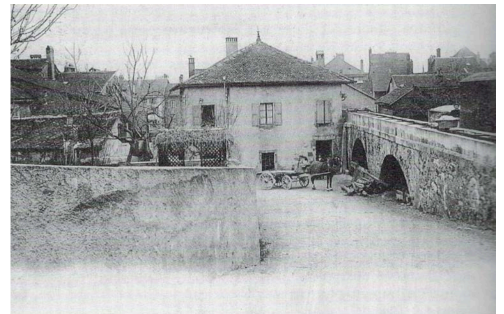
Le moulin et l'aqueduc, dernière section du Greny à ciel ouvert dans le bourg, en 1908
